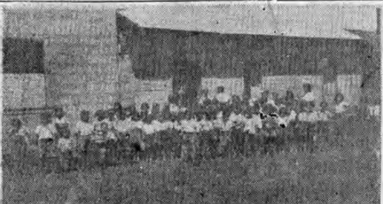
ESCUOLA DE SAN ISIDRO DE EL GENERAL. Nótese que en la parte central está partida y amenaza ruina
